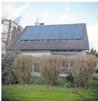
Die PV-Anlage liefert kostenlosen Strom für Haushalt, Heizung und Warmwasser.
