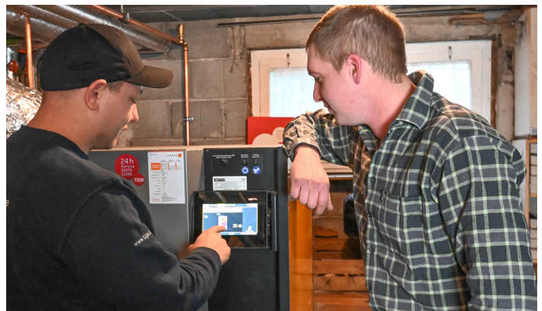
Gebäudetechnikspezialist TGS hat Lucas Brunner maximale energetische Unabhängigkeit ermöglicht.
