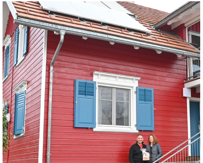
Großgastronom Martin Wilfonger hat sich den Traum von der eigenen PV-Anlage erfüllt und nutzt seither das absolute Maximum an Sonnenstrom.
