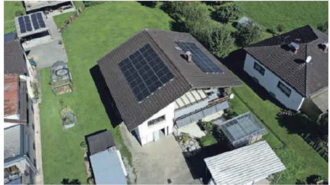
Dagma und Helmut Rappold produzieren mit ihrer 13-kWp-PV-Anlage selbst Strom und nutzen diesen für die Wärmepumpe.
